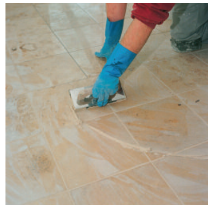
Mit PCI Carrafug können auch empfindliche Naturwerksteinbeläge sicher und verfärbungsfrei verfugt werden.
